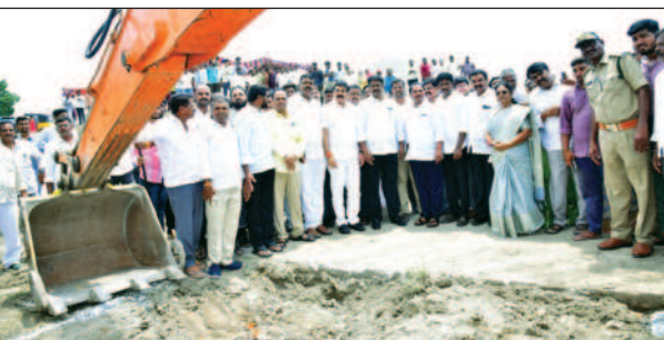
నిర్మాణ పనులను పరిశీలిస్తున్న ఎమ్మెల్యేలు, ఎంపి తదితరులు
